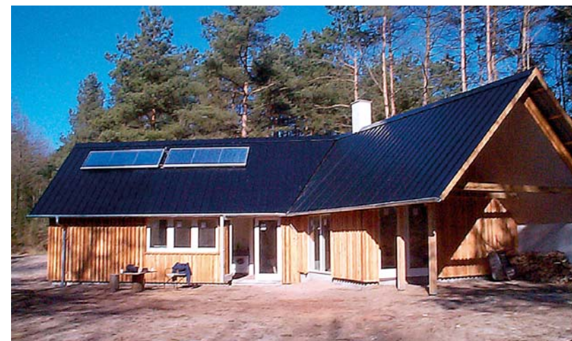
Entreprenørfirmaet Green Build opførte sidste år et 120 m 2 hus ved Thorsager nær Århus. Huset blev isoleret med papiruld, - 75 m 2 let ydervæg isoleret med 200 mm og 194 m 2 tag isoleret med 250 mm. Prisen for materialer og udførelse var 43.437 kr. inkl. moms. Den tilsvarende pris for mineraluld i henhold til V&S-prisbøgerne var 63.371 kr. - altså en merudgift ved brug af mineraluld på 45%! Der er en væsentlig arbejdskraftbesparelse forbundet med at anvende papiruld. Da arbejdskraften generelt er dyrest på Sjælland, er prisforskellen størst for Sjællændere!
