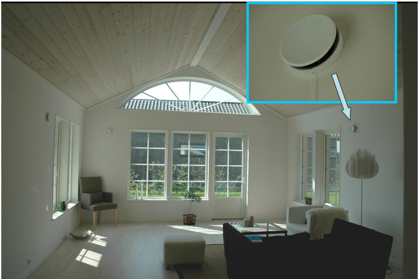
Luften kommer ind gennem ventiler i væggene - som ses forstørret op på det lille billede
