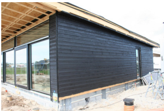
Hus under opførelse
